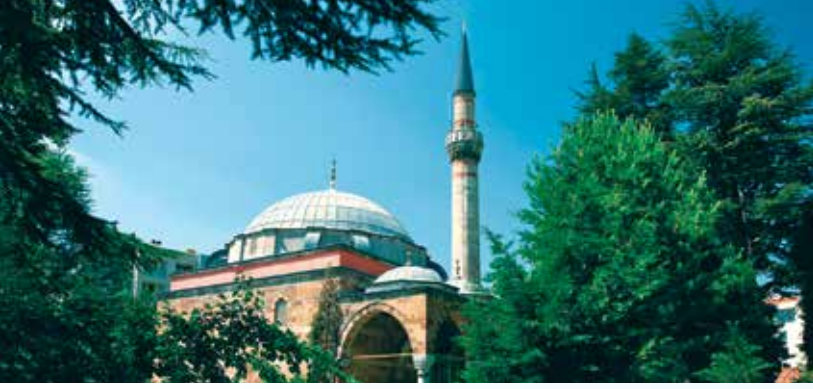
Bozöyük Kasım Paşa Camii
